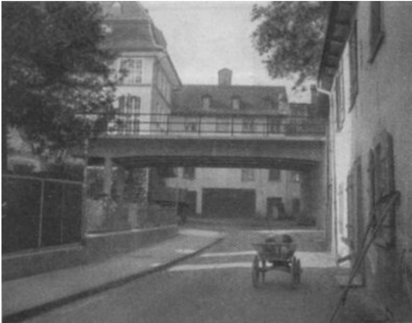
Neue Strassenbrücke für die
