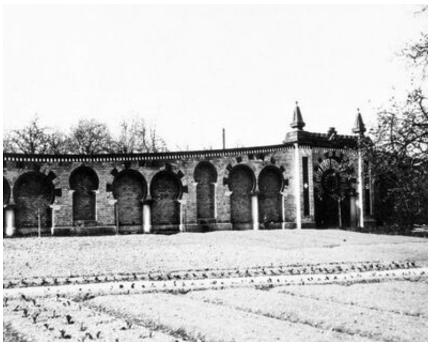
Windfangmauer entlang der
