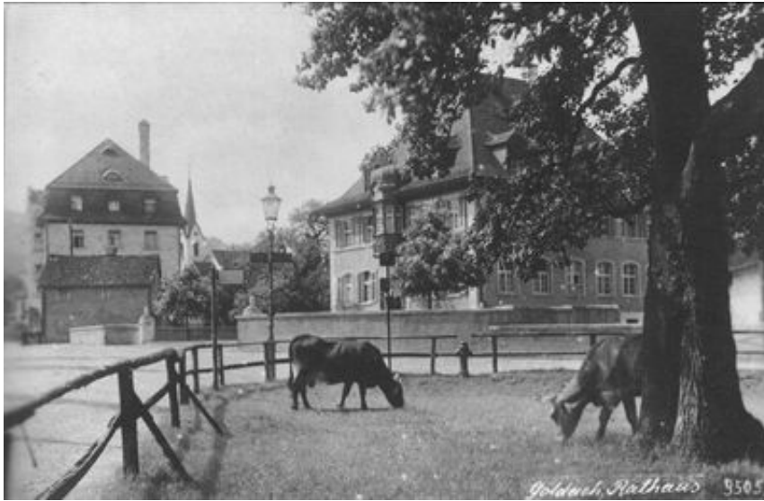
Rathaus Goldach, erbaut 1914/1915
