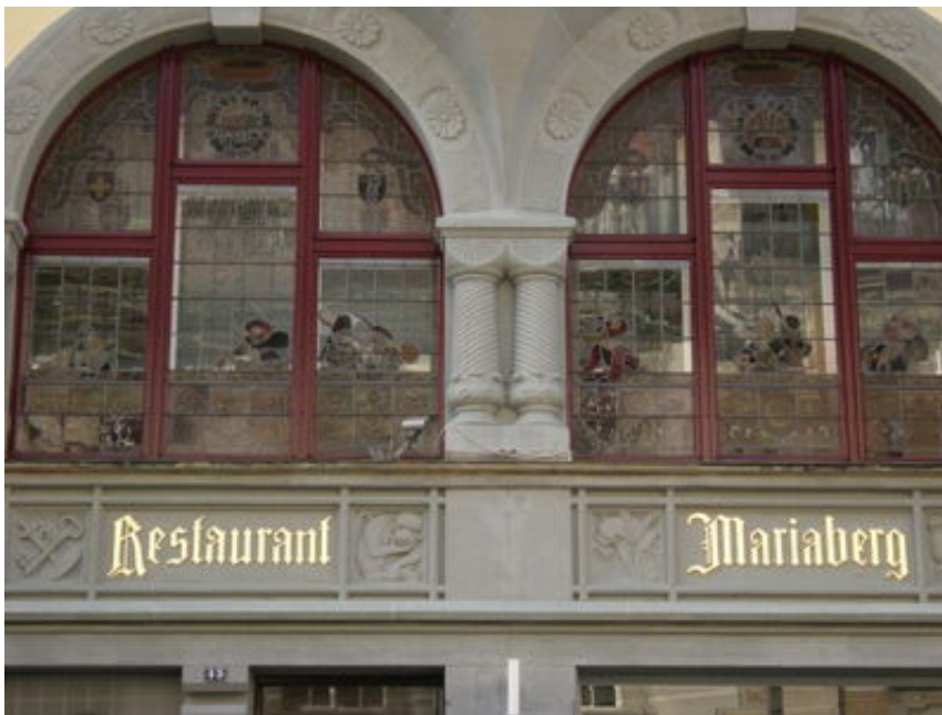
Fassade Mariaberg Hauptstrasse
