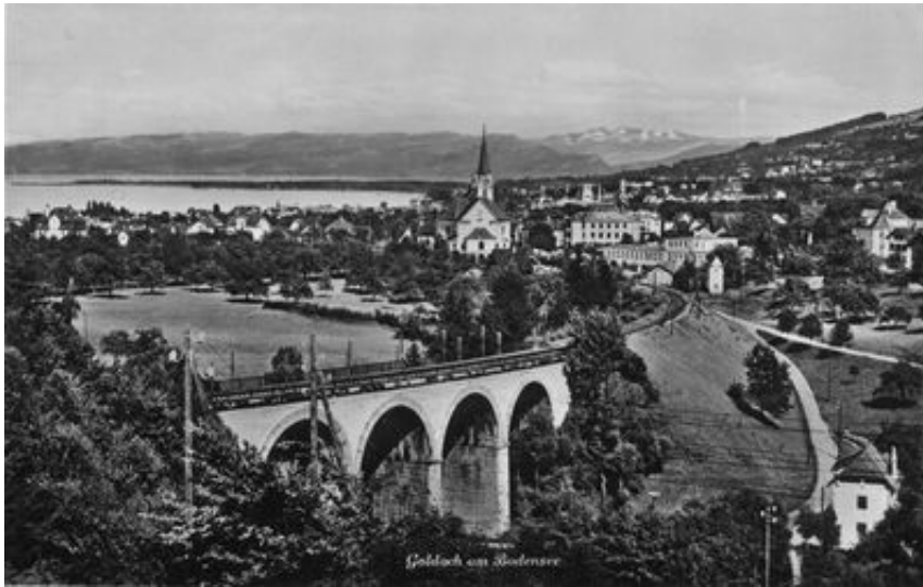
Eisenbahn-Viadukt über die Goldach,
