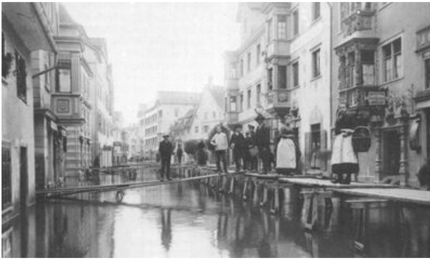
Die überschwemmte Hauptstrasse.
